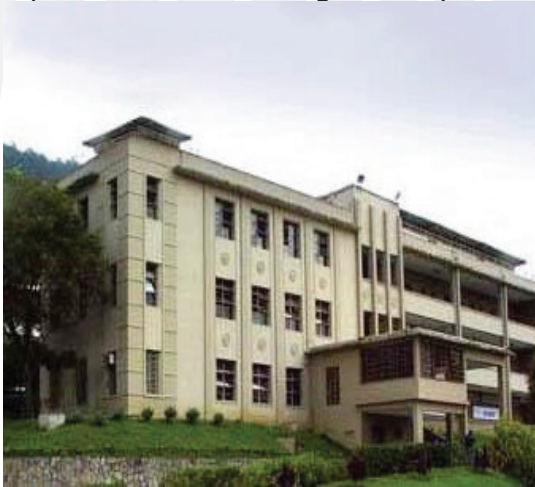
Fachada del Colegio La Salle La Colina
